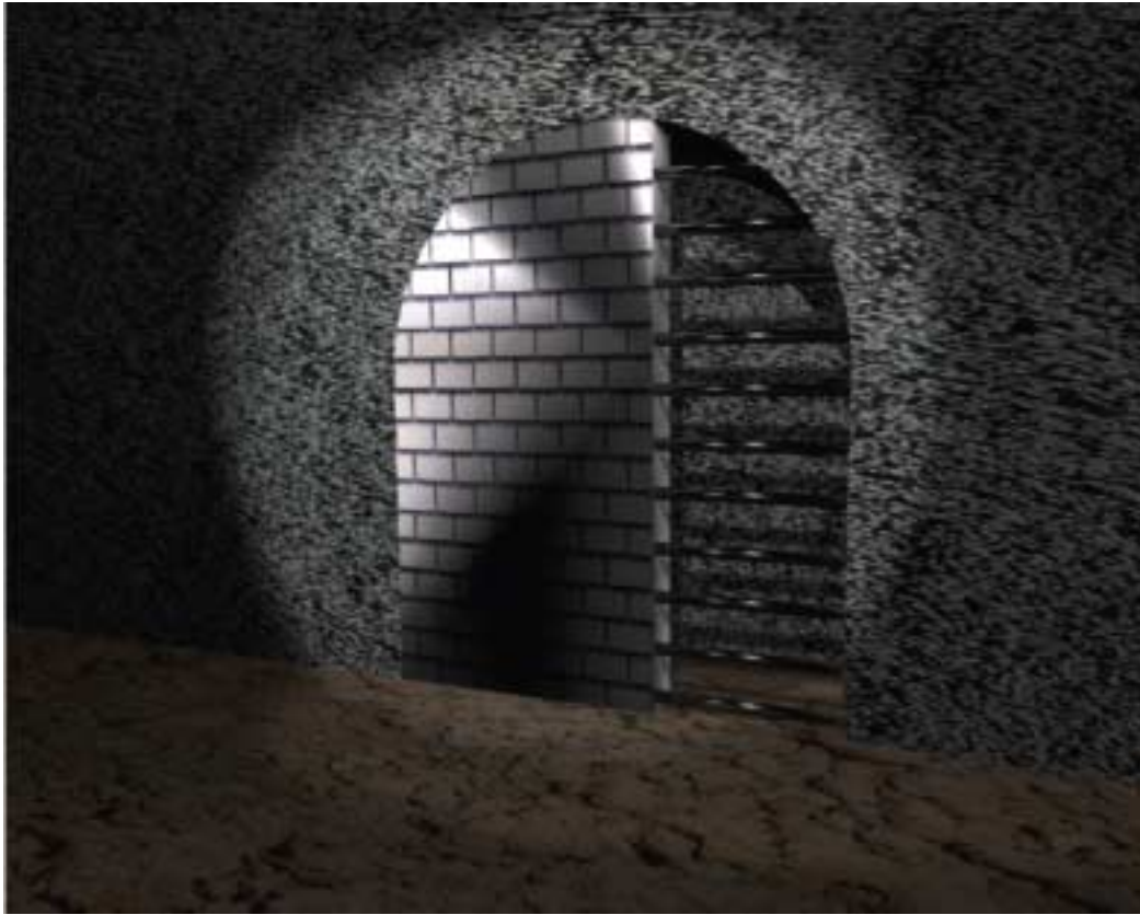
Abbildung 2 Nische, halbseitig mit Hohlraum doppelt vermauert, als Ausgleich für verloren gehende Hangplätze
