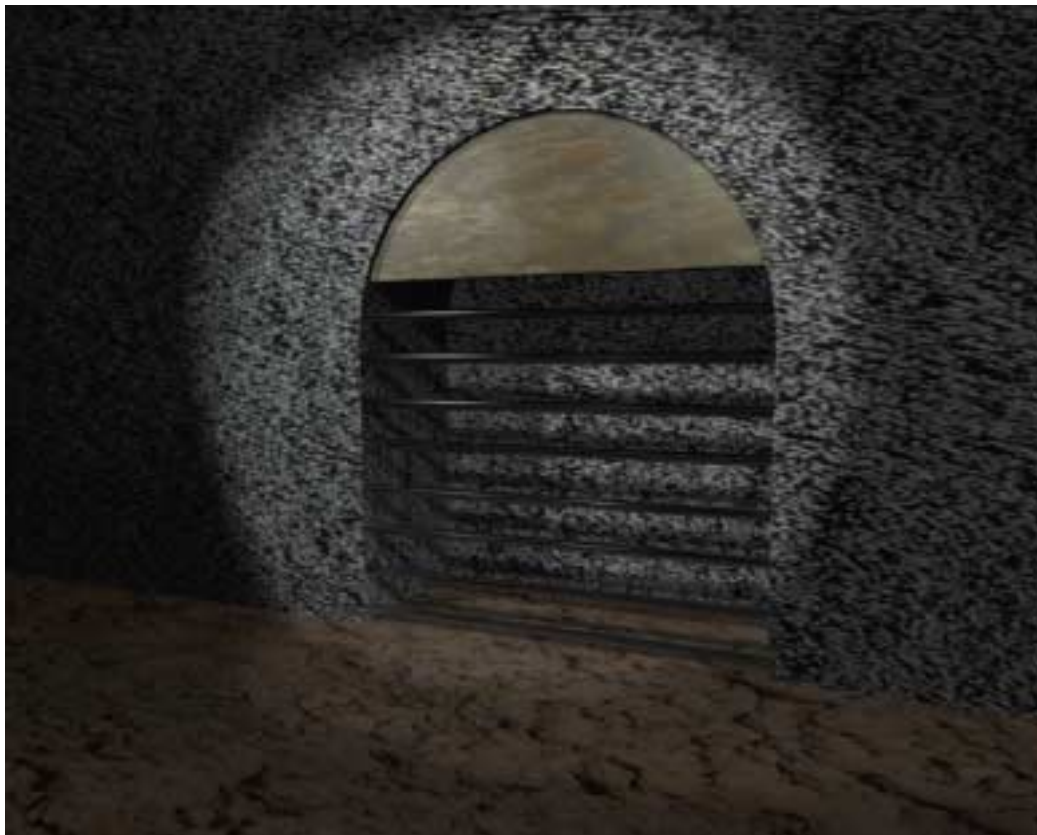
Abbildung 1: Horizontale Vergitterung einer für Fledermäuse als Hangplatz tauglichen Nische
